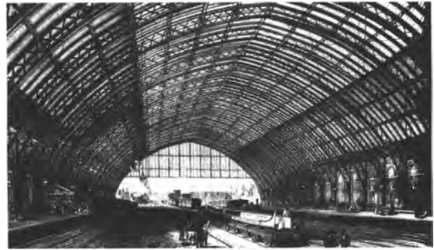
Figura 3 – Interior da Estação de Saint Pancras , Londres, c. 1870
